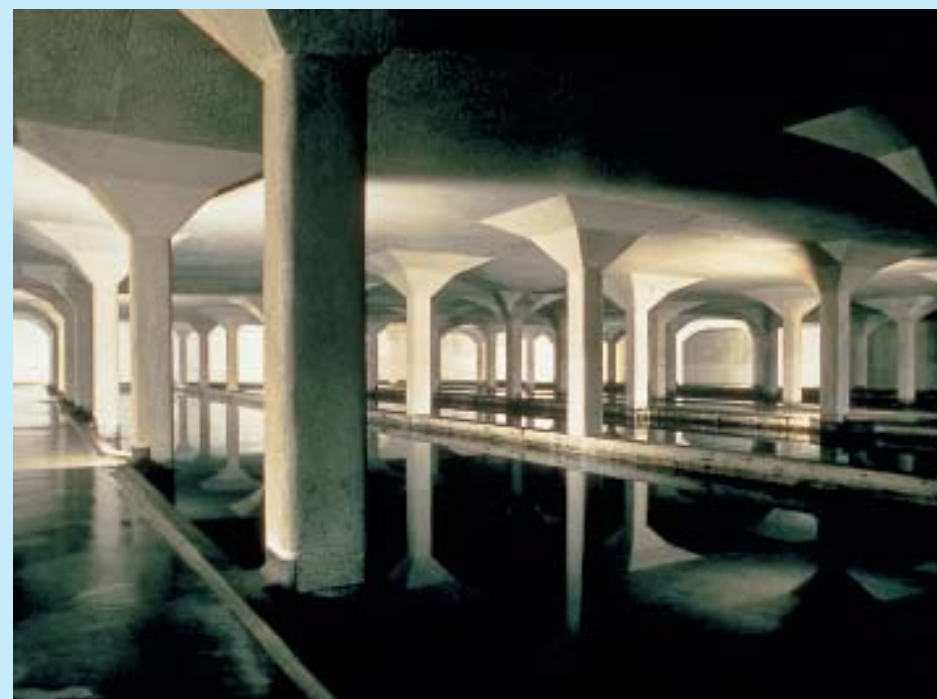
Im Zürcher Untergrund: Langsamfilter der Wasserversorgung.
