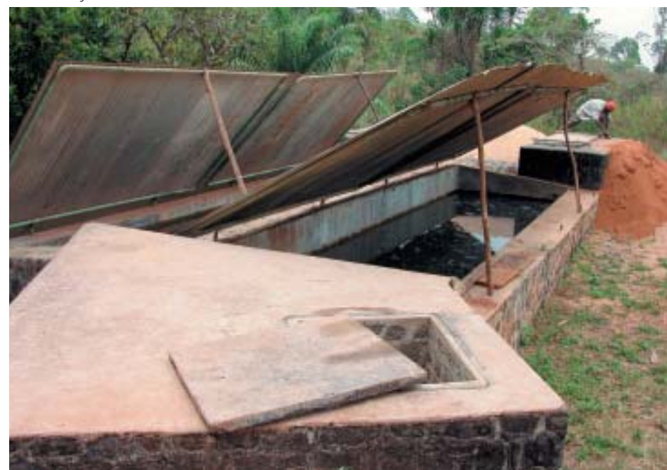
Das arbeitsintensive kamerunische Gegenstück zum zürcherischen Langsamfilter (S. 15): Jacob Asanji beim Waschen des Filtersandes.
