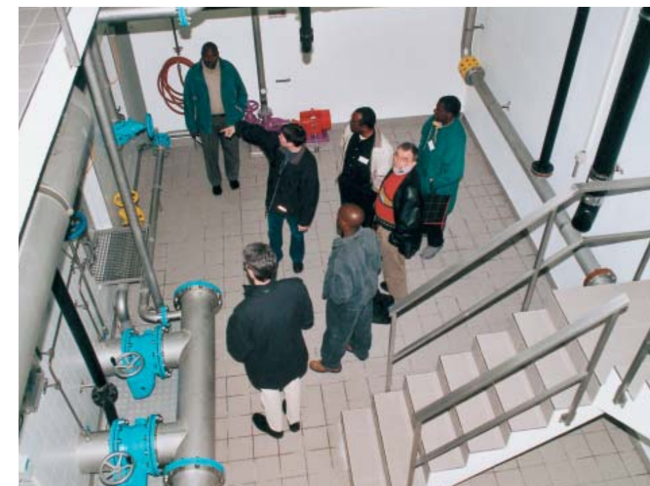
Besuch in Wittenbach: Die Gäste lernen hier das Modell einer kleinen, dezentralen Wasserversorgung kennen.
